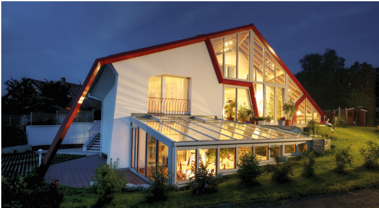
Quelle: BAUMANN Wintergarten GmbH, Stockheim Foto: Stefan Diller / @Saint-Gobain Glass
